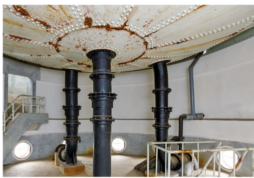
配水タンク。当時は大型プレス技術はなく、三角形のパーツをリベット接合して丸底にした
