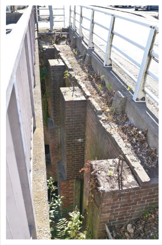
逆流時には板を挟み込み防止した
