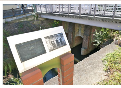
樋門の傍らにある 選奨土木遺産顕彰碑
