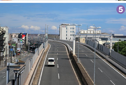
⑤ 殿町地区から浮島方面の自動車専用部は高架構造になる
