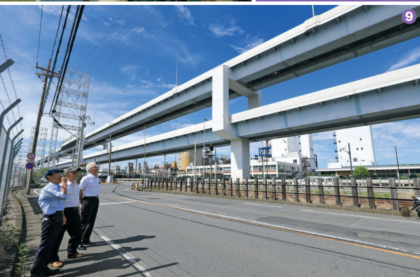
⑨ 浮島地区の自動車専用部(高速川崎縦貫線)はラケット構造の橋脚で上下に分けた
