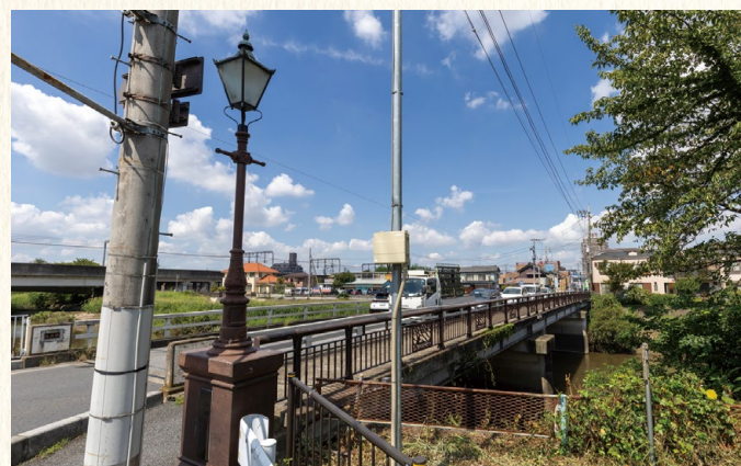
越ヶ谷町と大沢町とを結ぶ大沢橋
