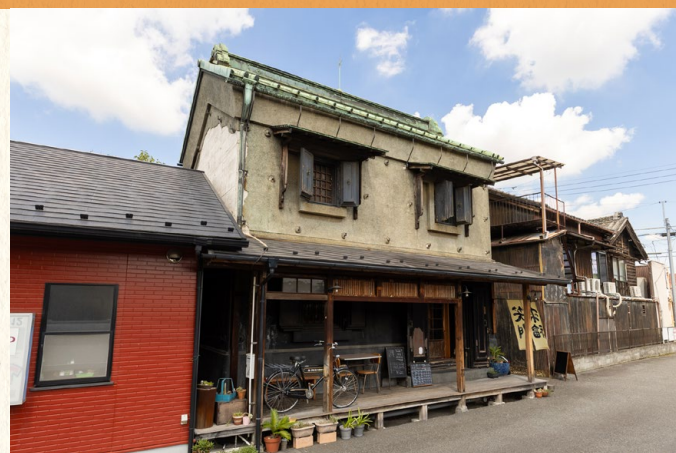
古民家をリノベーションした靴屋
