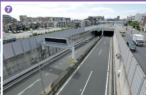
⑦ 殿町地区から大師JCTまでの自動車専用部は地下道路に。「小学校(右奥の建物)前は通学路。安全と、排気ガス・騒音の抑制のためにも地下にするのがよいと考えたのです」(伏見さん)
