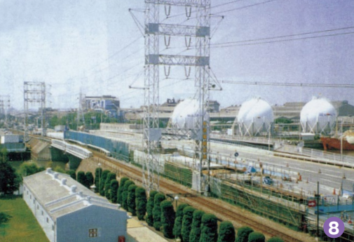
⑧ 浮島地区を横切る多摩運河に架かる浮島橋の架替え工事の様子 (提供:川崎国道事務所)
