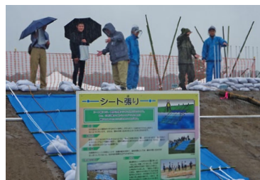
水防工法を説明する防災エキスパート
